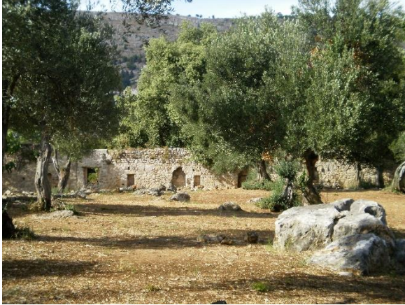
Slika 5. Lazaret na Lokrumu
